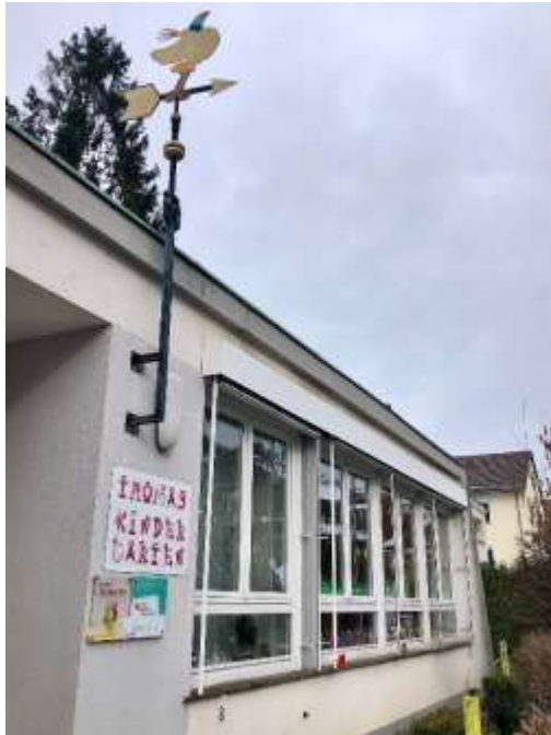
Bestandsgebäude des Kiga; wird abgerissen
