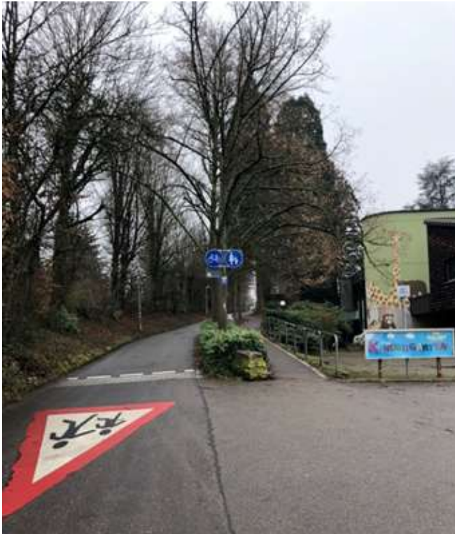
Beginn des Fuß-und Radwegs am Gemeindezentrum St. Blasius im Burgdorfer Weg
